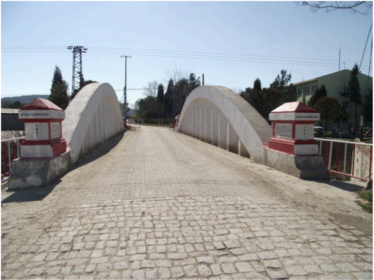
Atav Köprüsü, 1931 yılında Atatürk tarafından İnşaat Yüksek Mühendisi Ferruh Atav'a inşa ettirildi.
